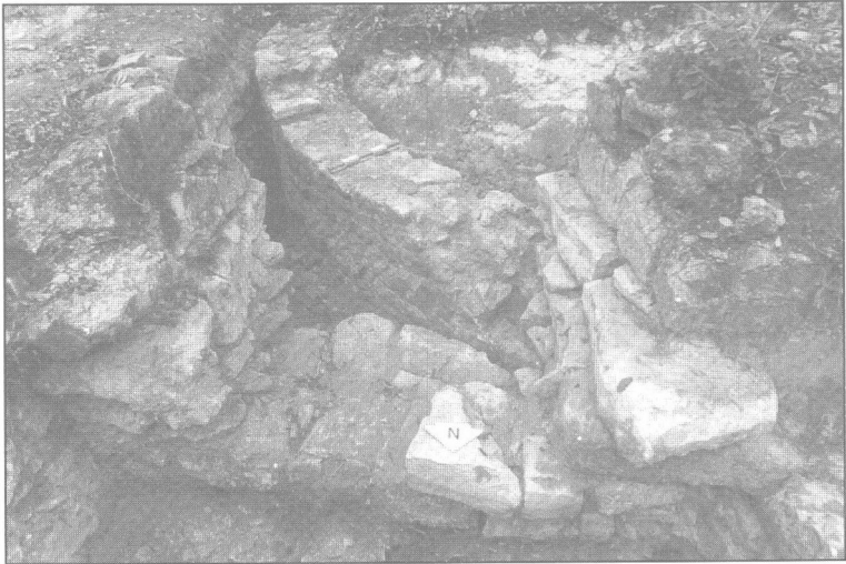
L'abside de l'église carolingienne. A droite, on voit la pile sud du clocher de l'église du XII e siècle, dont la construction a détruit une partie de l'abside.
