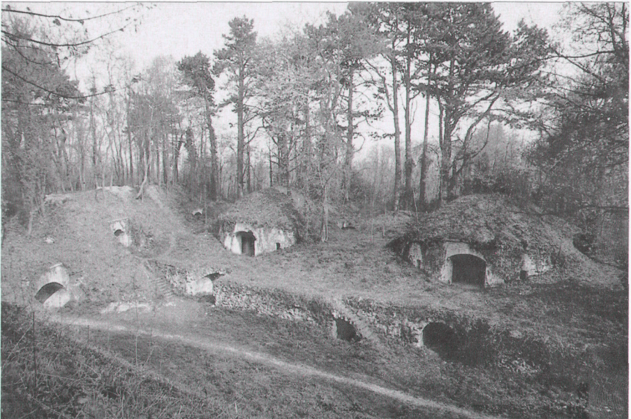
Fig. 7 : Fort de Condé-sur-Aisne, rue du rempart et traverses 8, 9 et 10 (cliché Martin Barros).
