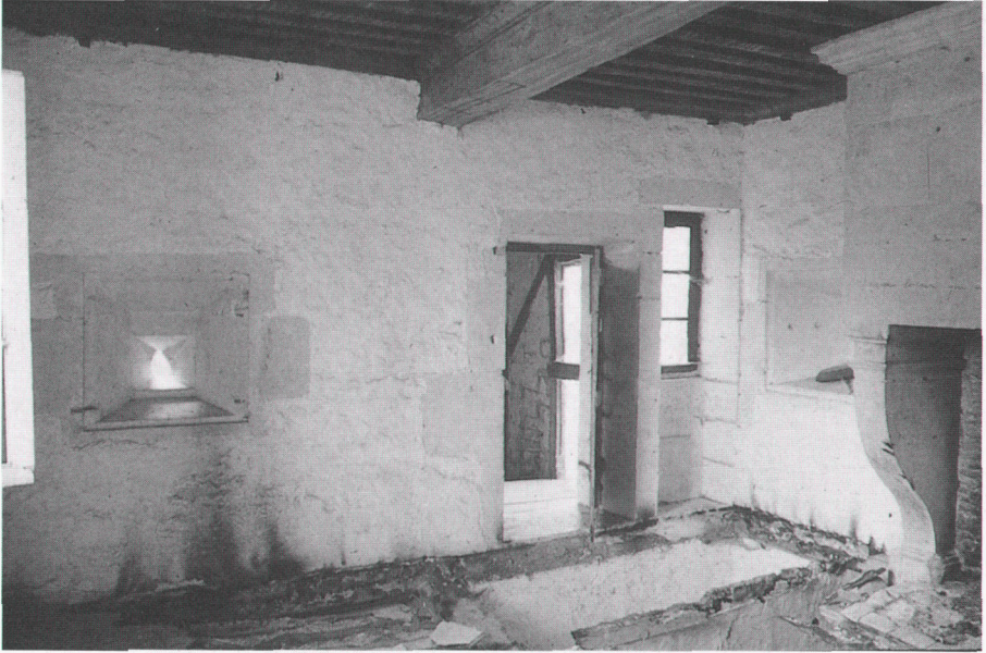
Fig 14 : Serzy-et-Prin (Marne), château de Prin, la chambre d'étage d'un des pavillons flanquants de la plate-forme castrale ; on note la canardière pour le mousquet (cliché C. Corvisier).
