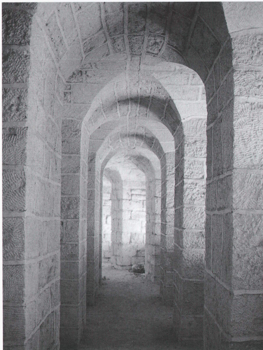
Fig. 12 : Fort de Condé-sur-Aisne, couloir de fusillade de tête de la caponnière double (cliché Martin Barros).
