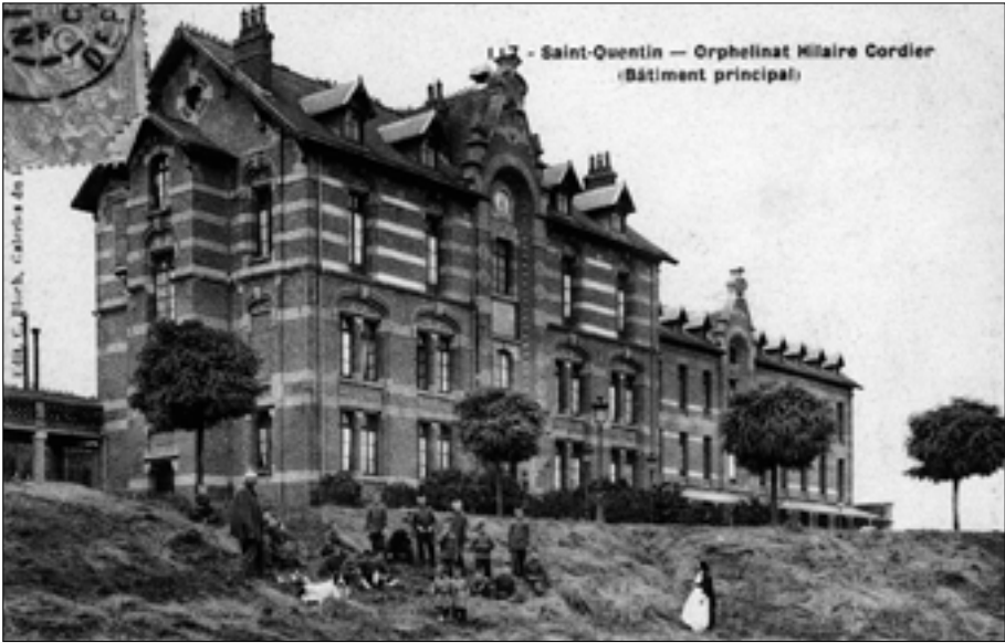
Vue du bâtiment principal de l'hospice Cordier. Coll. part.
