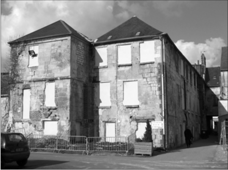
Emplacement où s'élevait l'hôpital de la Charité. Travaux en cours (2005). Cliché A. Arnaud.
