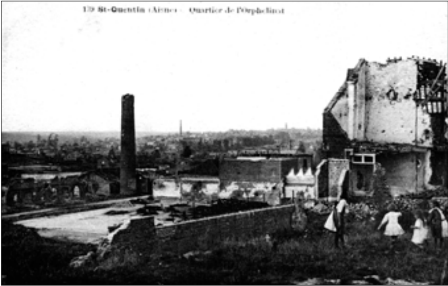
Quartier de l'orphelinat après les destructions de 1917-1918. Il ne reste rien du bâtiment. Coll. part.
