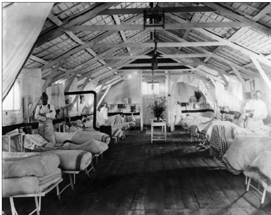
Salle d'hospitalisation en période de calme.
